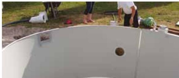
Fixez les pièces à sceller à l'aide des vis fournies à la paroi, collez les joints adhésifs du skimmer (2 joints : 1x sur le skimmer, 1x coté intérieur piscine, la bonde de fond, les buses de refoulement, prise balai, spots, escalier...
