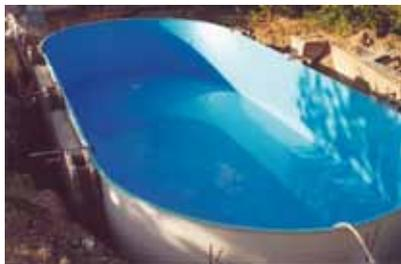
Commencez à remplir la piscine tout en repoussant avec précaution les plis du centre de la piscine vers la paroi. Arrêtez le remplissage après 2cm. Éliminez maintenant les derniers plis sur le fond en les tirant vers l'extérieur. Attention, le liner sera toujours de dimensions inférieures à la tôle et la pression de l'eau atténuera encore l'effet des plis.
