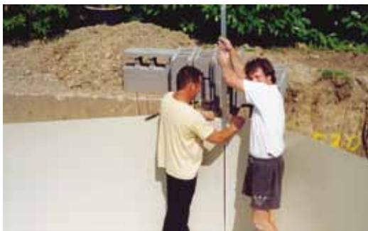
Fixez la tôle sur le mur de maintien au dessus de la ligne d'eau à l'aide des vis et chevilles fournies.
