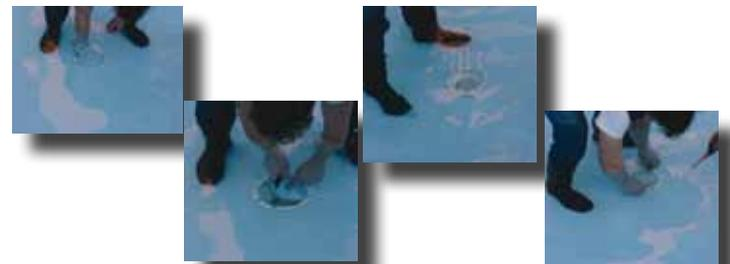
Remplissez la piscine jusqu'à 10 cm sous la première pièce à sceller. Fixez les brides d'étanchéité. Sachez que la plupart des petits plis dans le fond disparaîtront par la pression d'eau.
